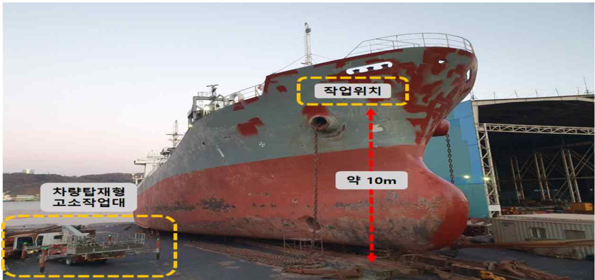
【사고당시 사용 장비(차량탑재형 고소작업대 및 재해발생 위치)】
